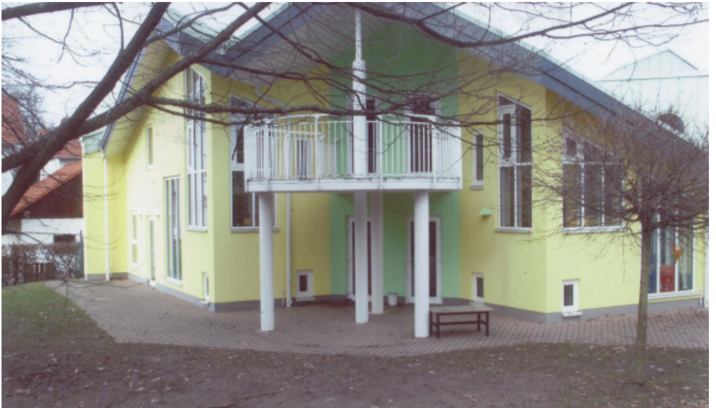
Objekt 5: Heinrich-Hofmann-Str. 1 c, 63584 Hasselroth-Niedermittlau
