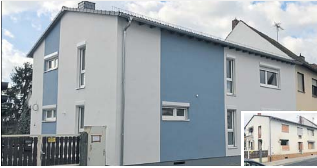
Das nach der Neugestaltung zweifarbige Gebäude steht in der Hauptstraße der Gemeinde Hammersbach im Altkreis Hanau.
