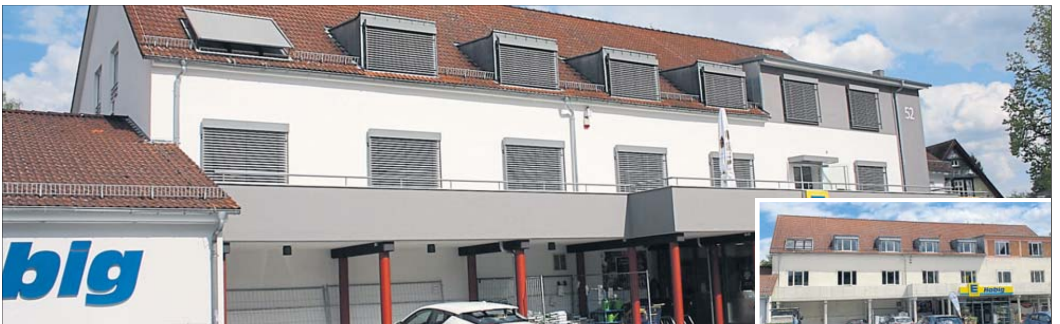
Die Neugestaltung dieser Einkaufsmarkt-Fassade in der Bad Sodener Straße im Stadtteil Salmünster hat die Jury ebenfalls für finalwürdig angesehen.
